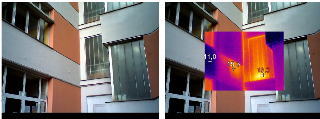
Figura 1.2 – Rilievo termografico della parete
