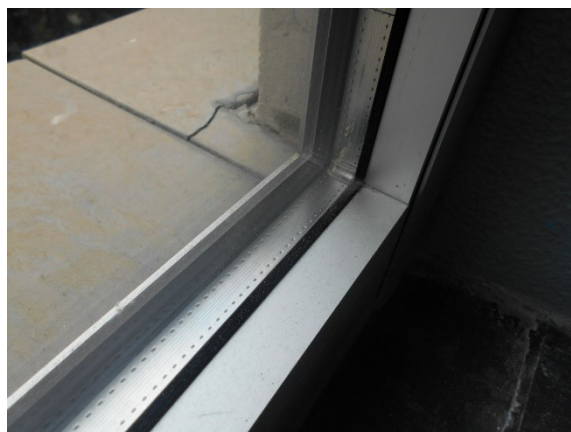
Figura 2.2 – Particolare dei serramenti – dettaglio angolo doppio vetro
