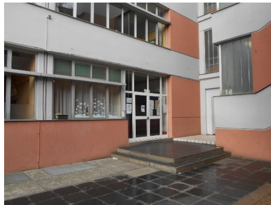
Figura 1.1 – Particolare dell’ingresso principale
