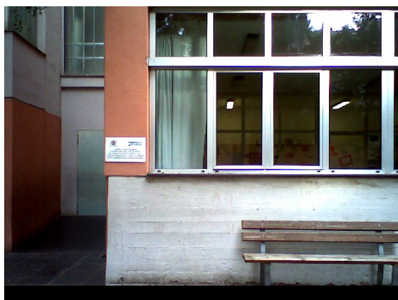
Figura 2.3 – Rilievo termografico dei serramenti
