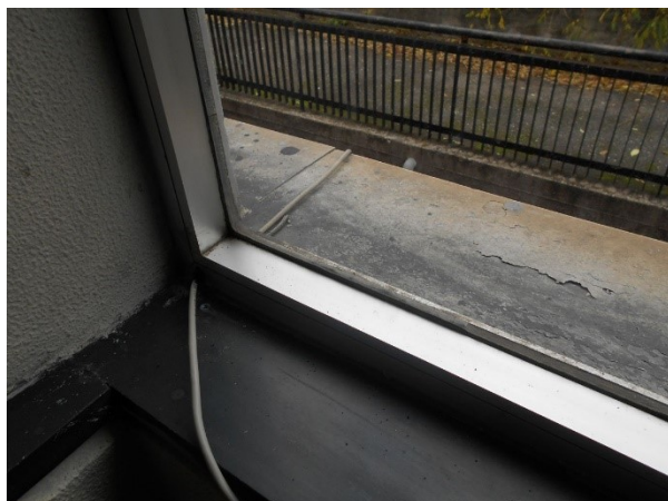
Figura 2.1 – Particolare dei serramenti – dettaglio angolo singolo vetro
